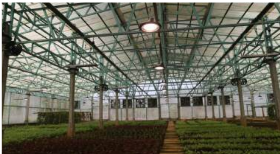
Chiếu sáng Smart Farm tại Hòa Bình
